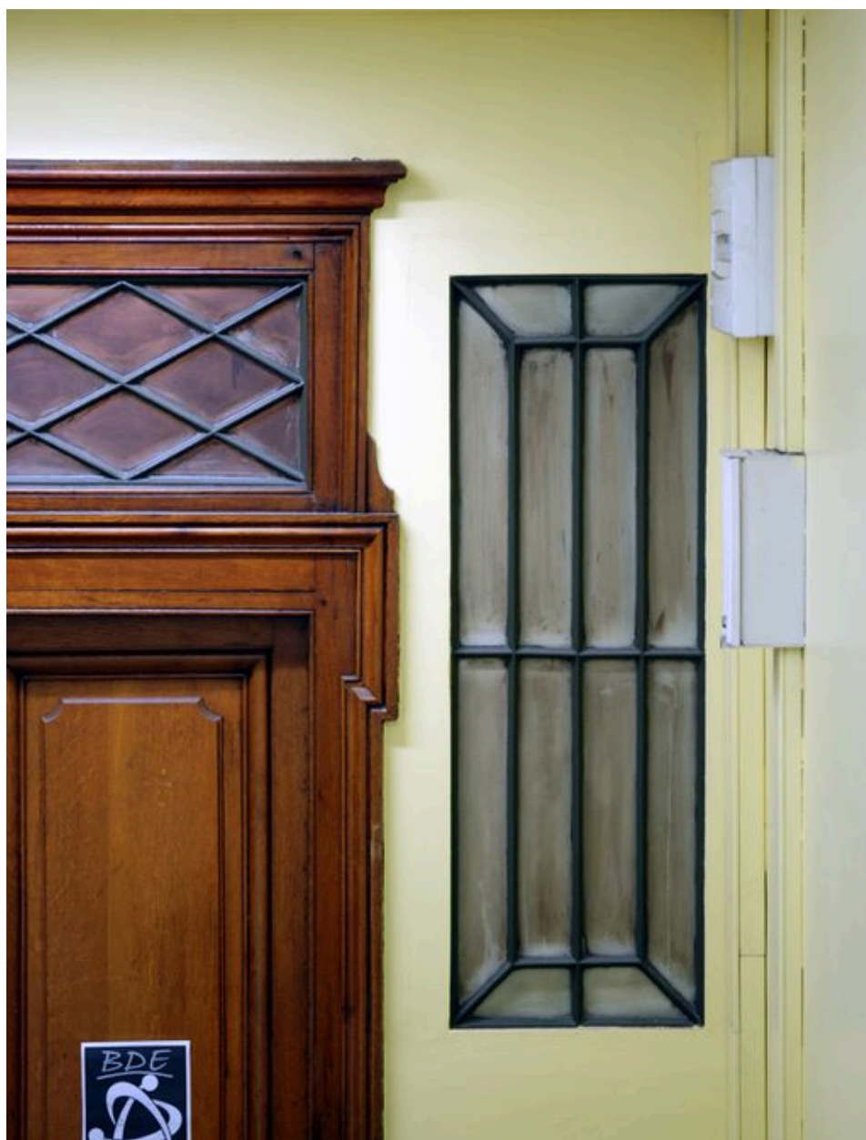
Cage d'escalier, détail d'un fenestron
