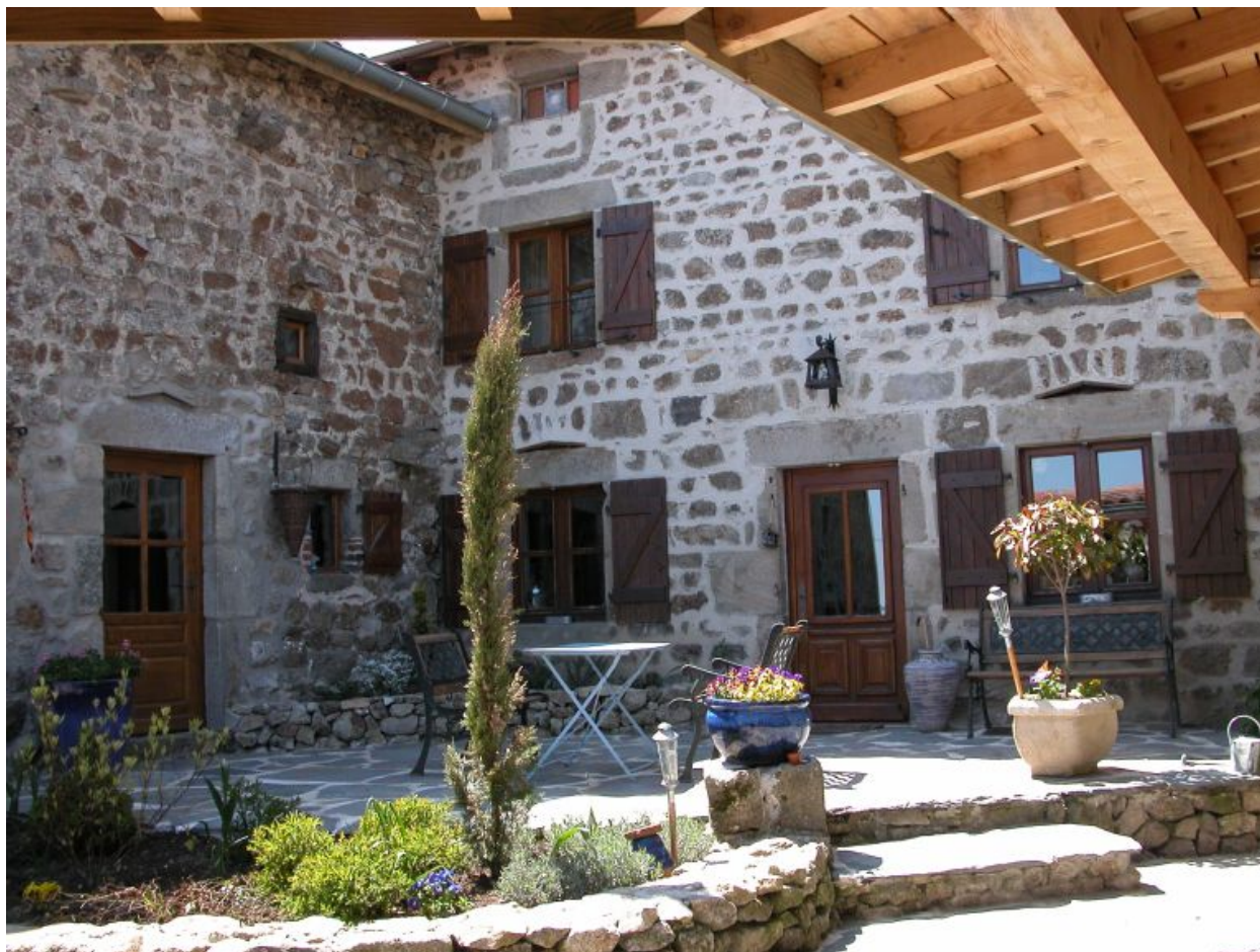
Détail de la façade du logis.
