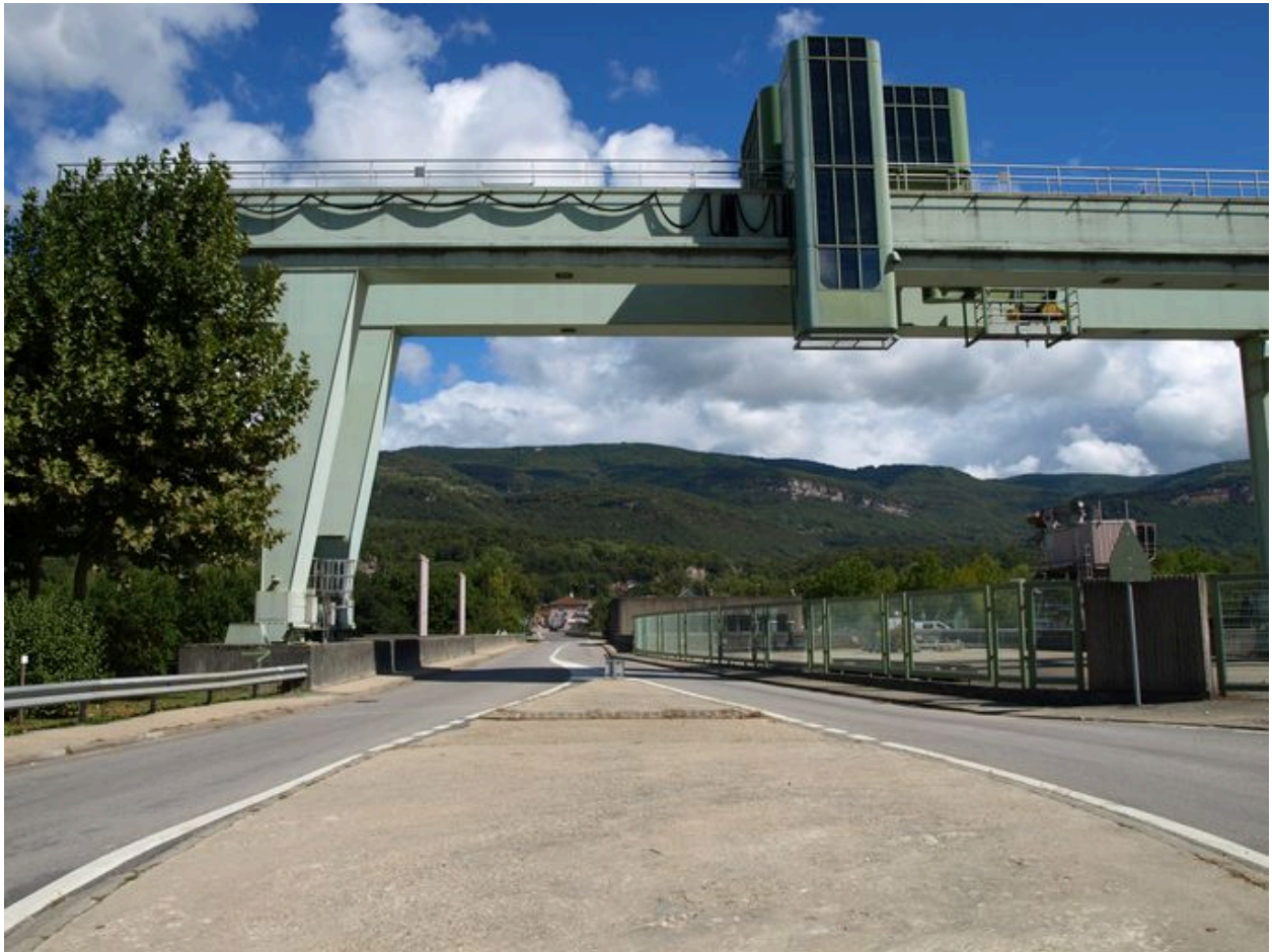
Vue de la chaussée du pont et de la centrale (depuis la rive gauche)
