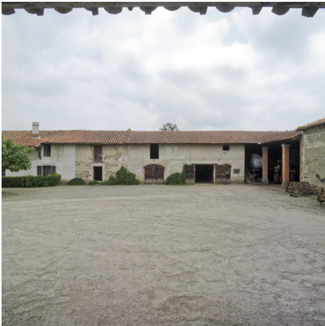
Vue d'ensemble du côté est de la cour, depuis le hangar sud-ouest.
