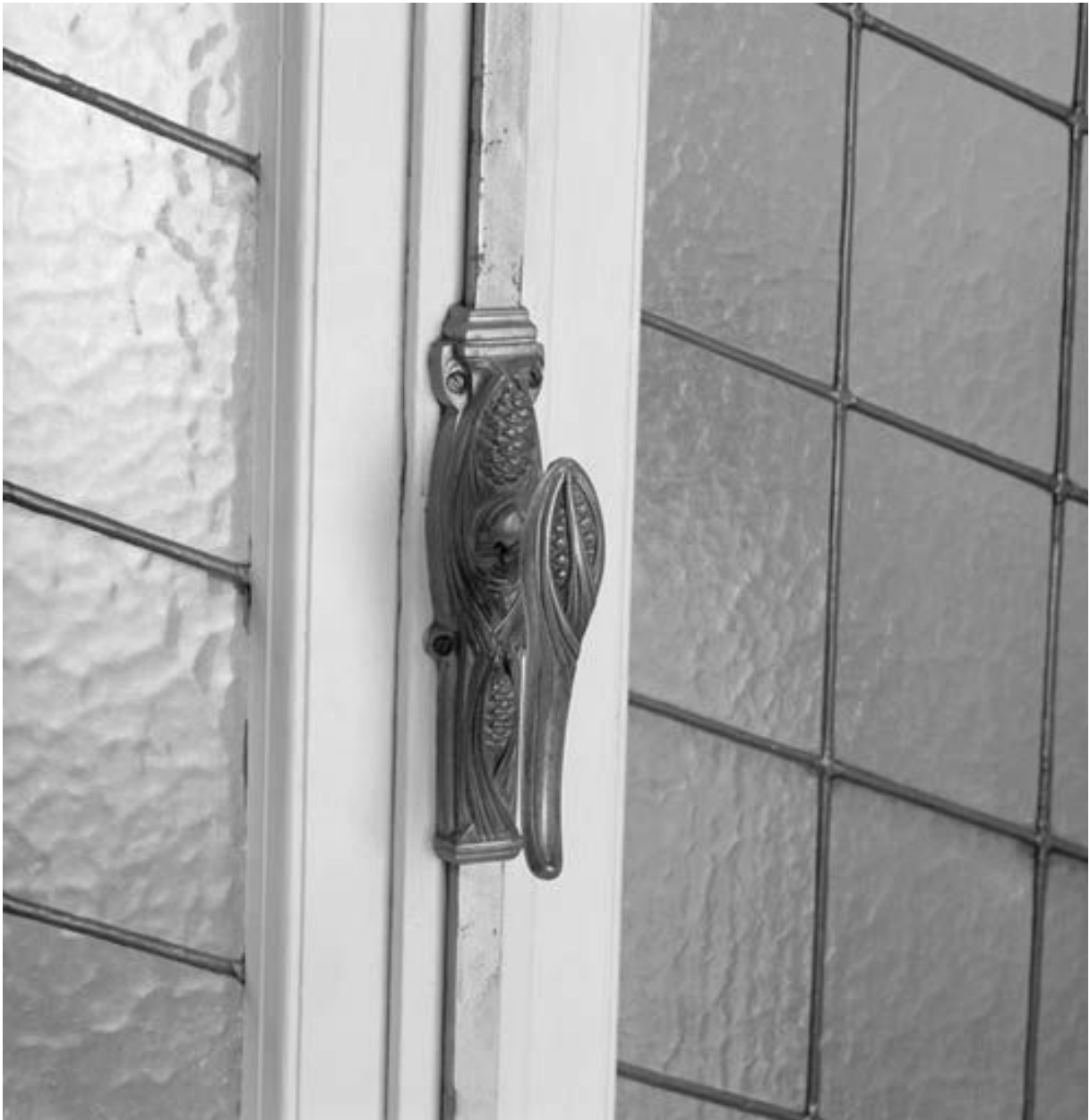
Fenêtre éclairant la cage d'escalier : détail de la poignée
