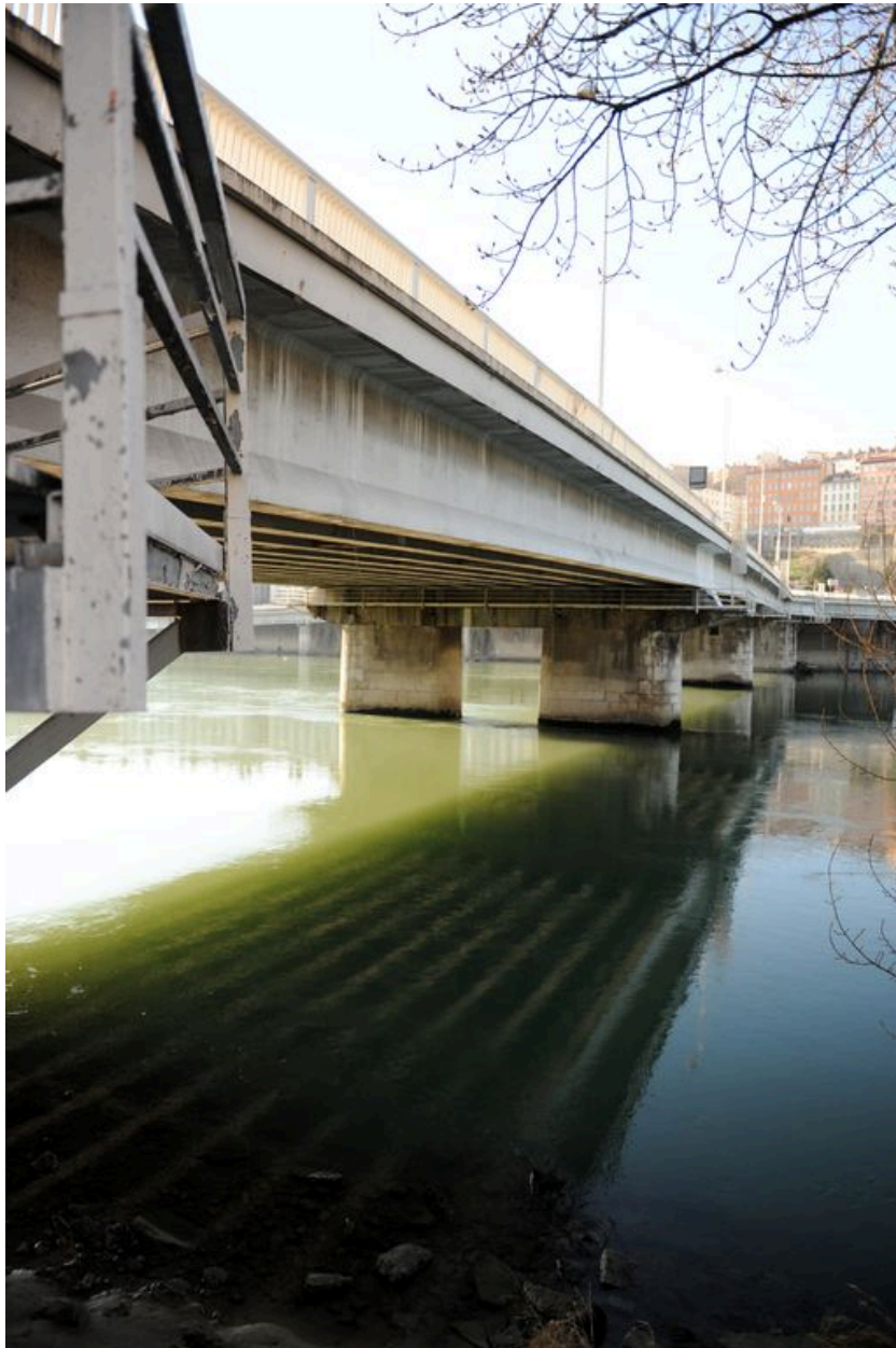
Vue générale, de côté, face amont (depuis la rive gauche)
