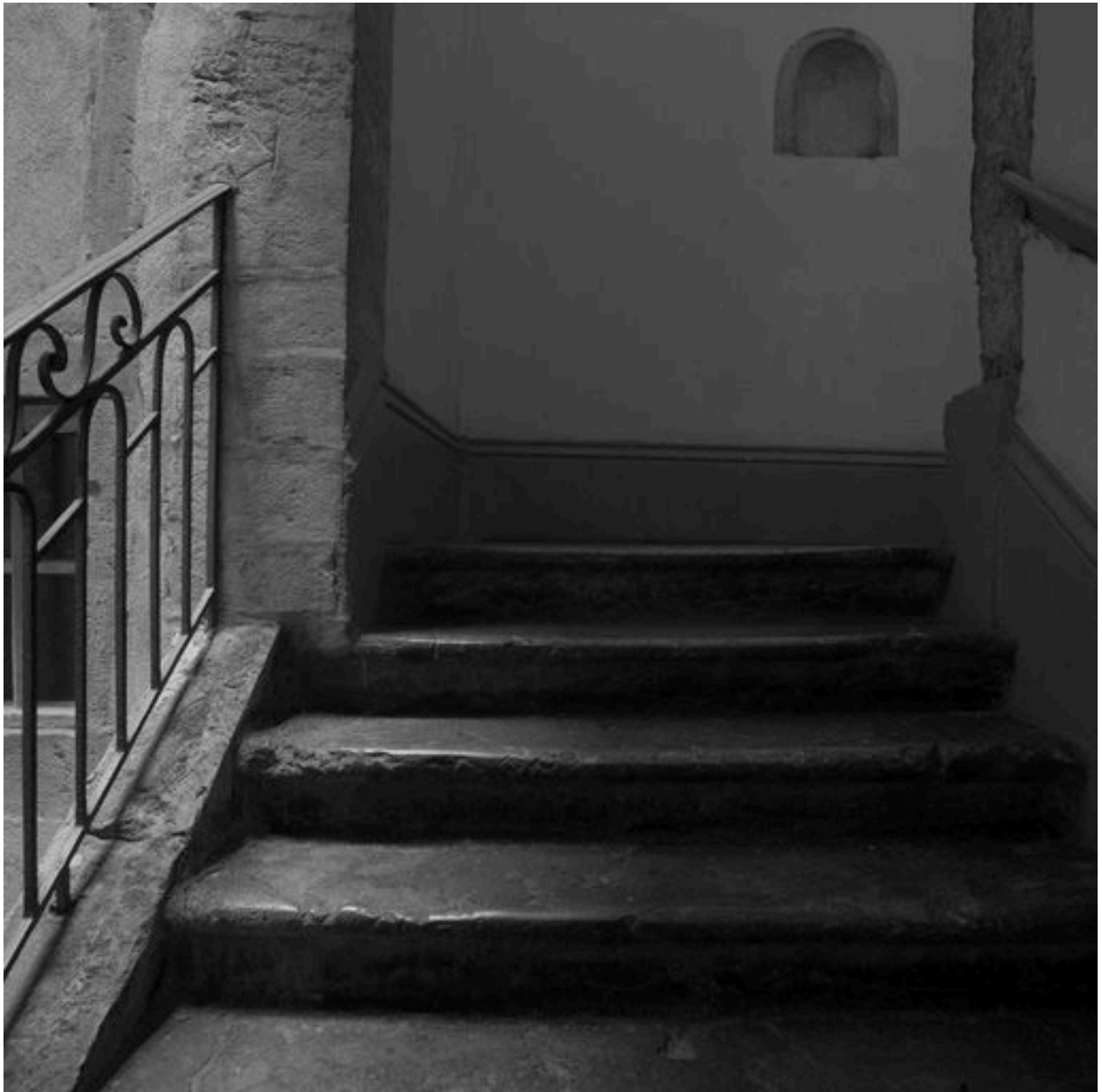
2e étage d'escalier, repos et niche à lumière
