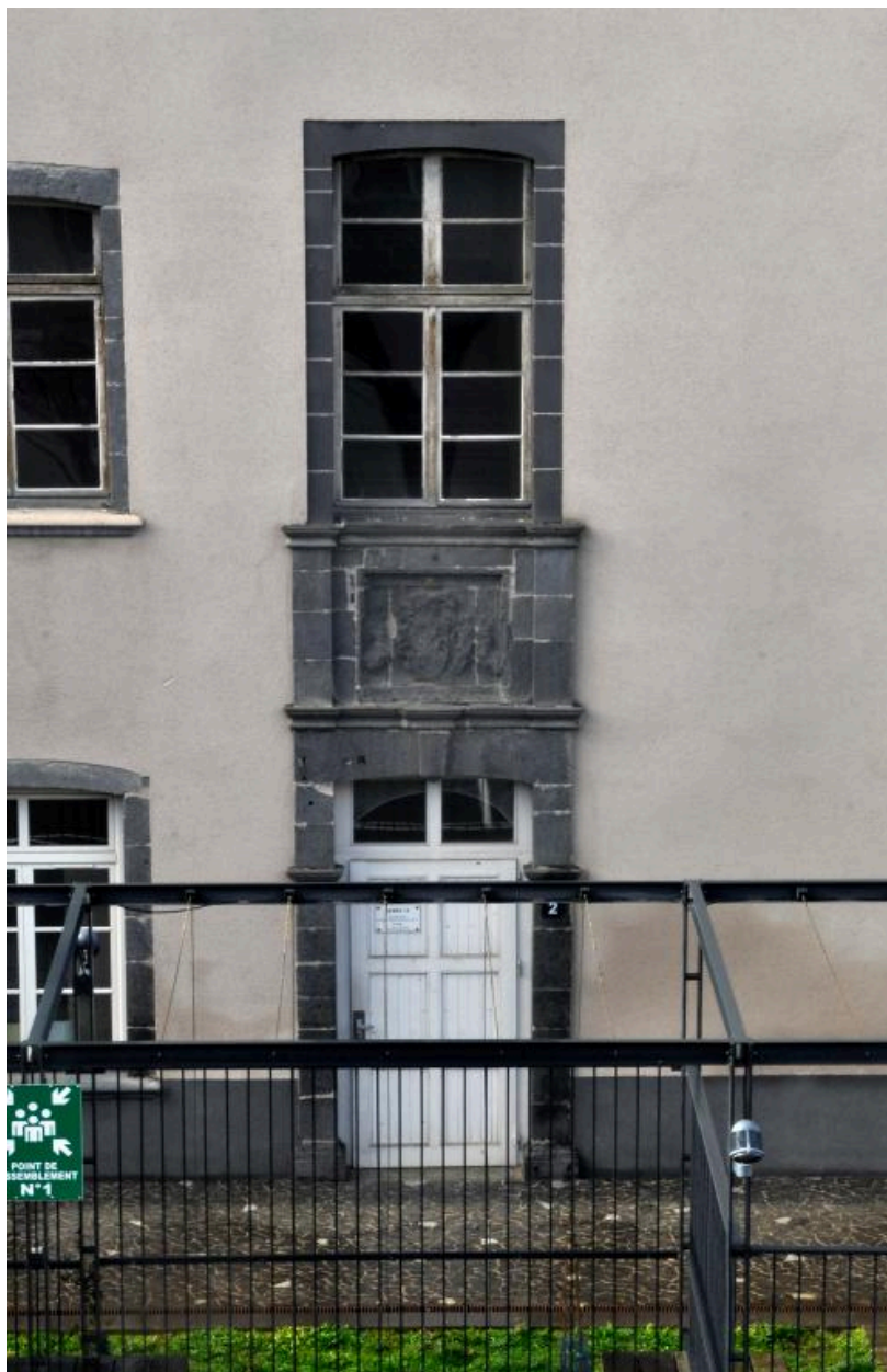
Corps de bâtiment ouest : ancienne entrée du collège jésuite (?)
