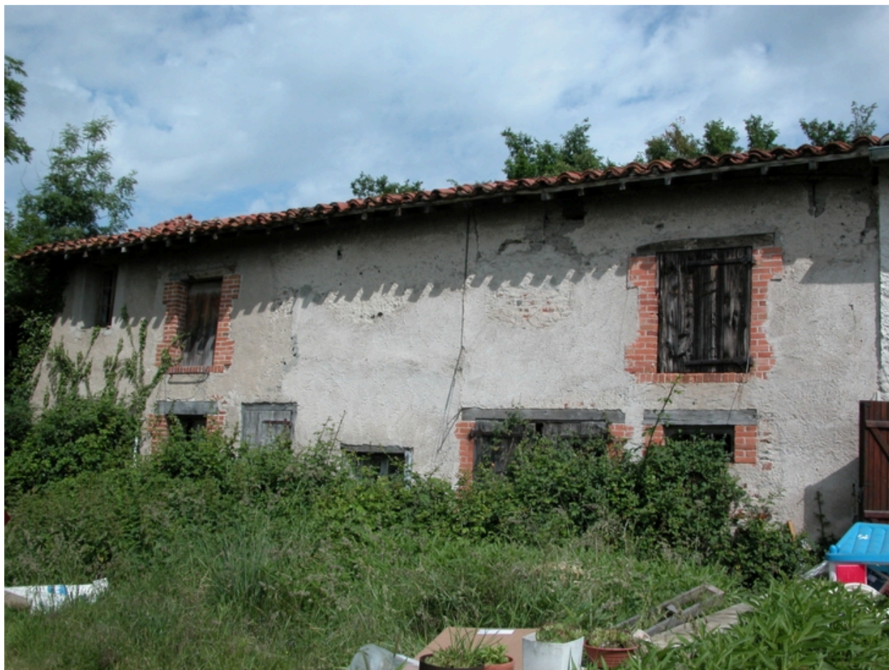
Vue partielle du bâtiment nord, depuis le sud.
