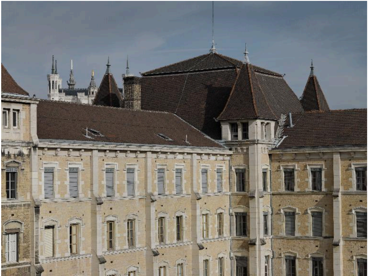
Corps de bâtiment principal et aile nord : détail de toitures
