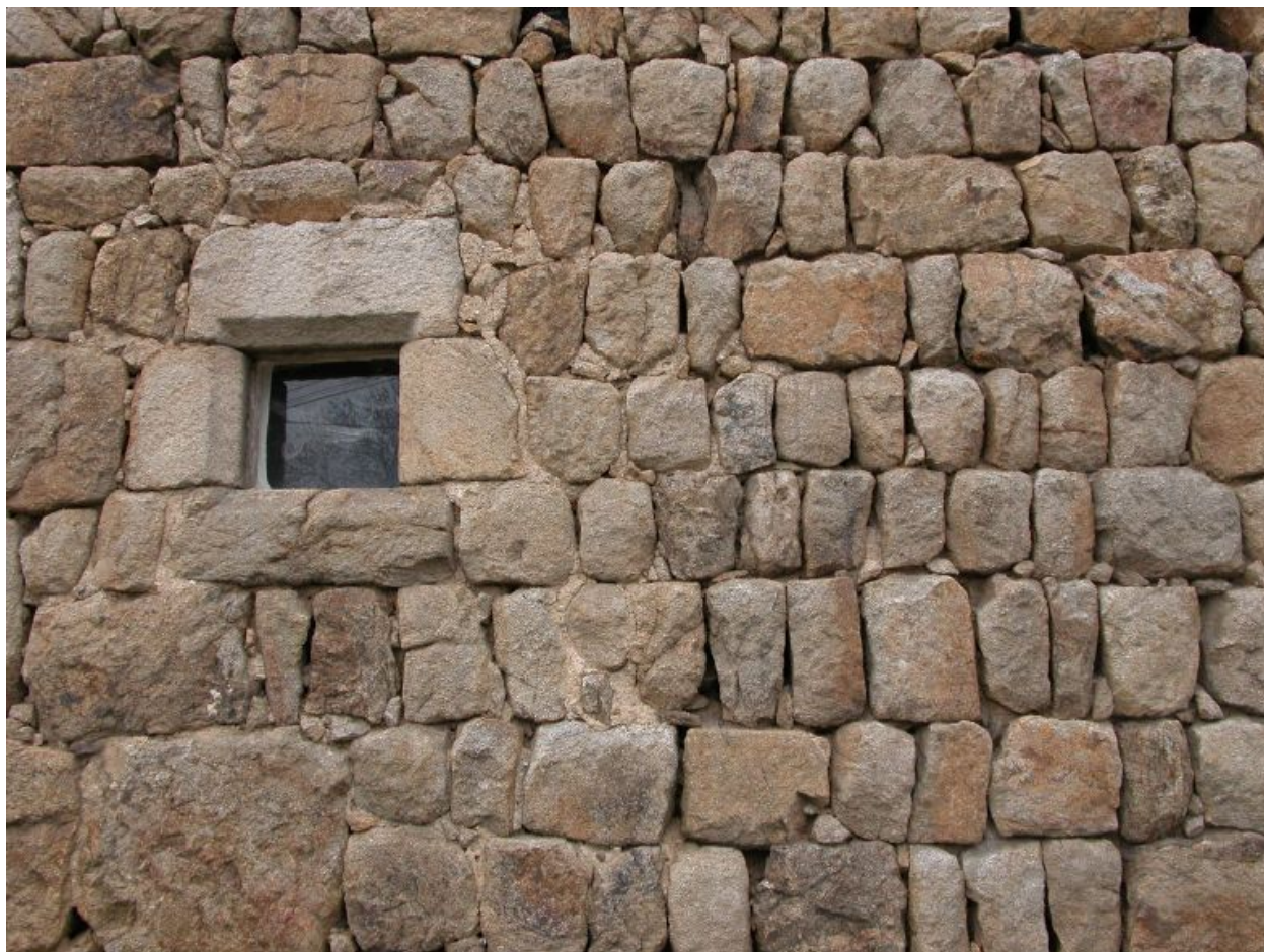
Etable est, détail de la mise en oeuvre du mur pignon.
