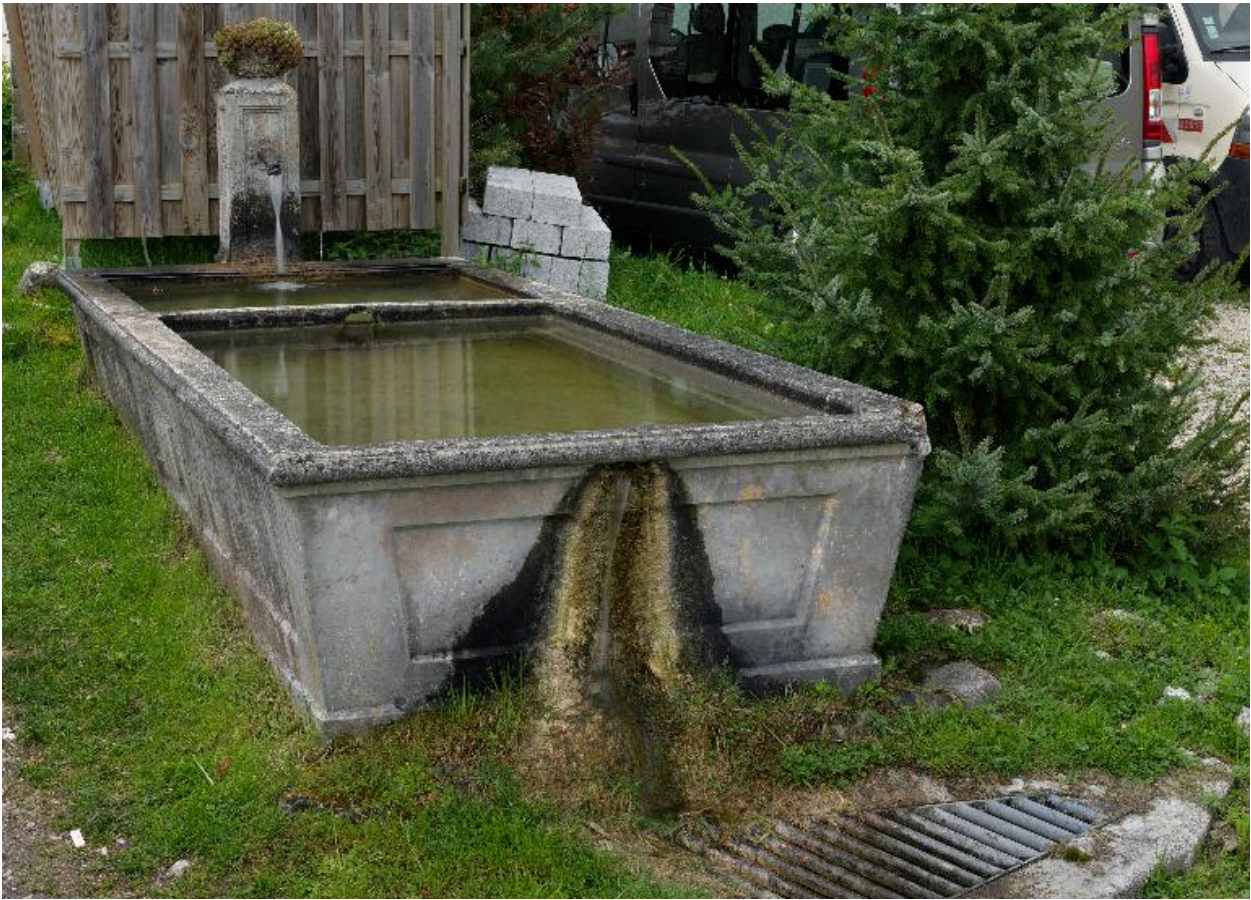
Vue d'ensemble de trois-quart.
