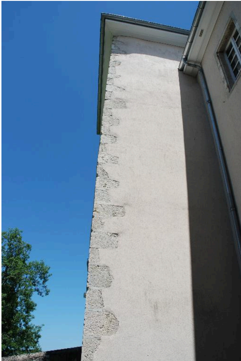
Tour nord-ouest du château, vue latérale du fruit de la tour.
