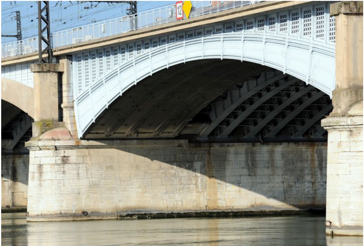
Arche en acier, face aval, vue générale (depuis la rive gauche)
