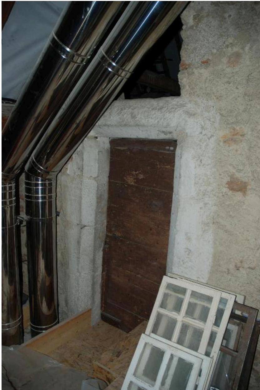
Comble à surcroît. Porte d'accès à l'espace de la tour nord-ouest.
