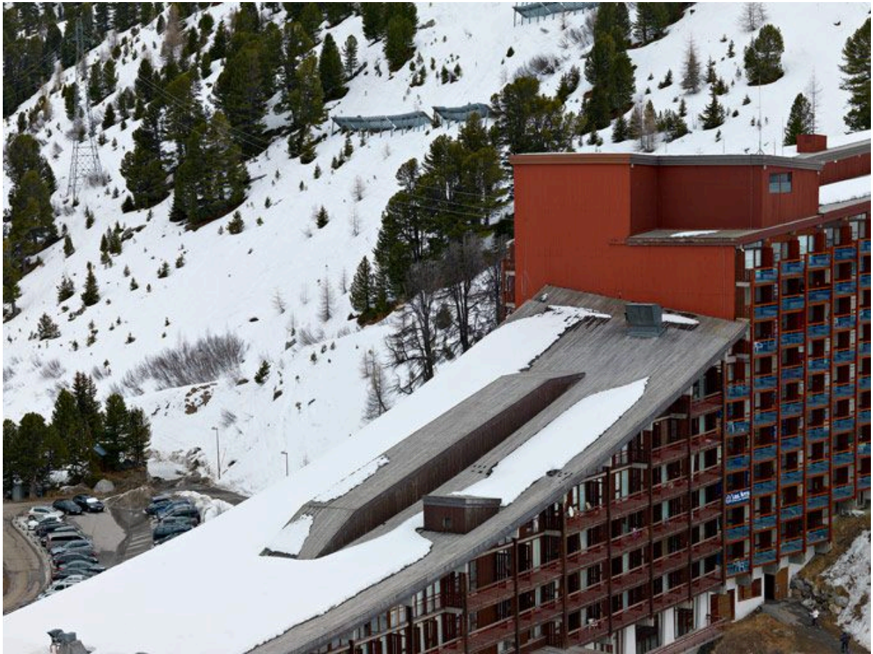
Jonction entre les deux corps de bâtiment depuis l'ouest
