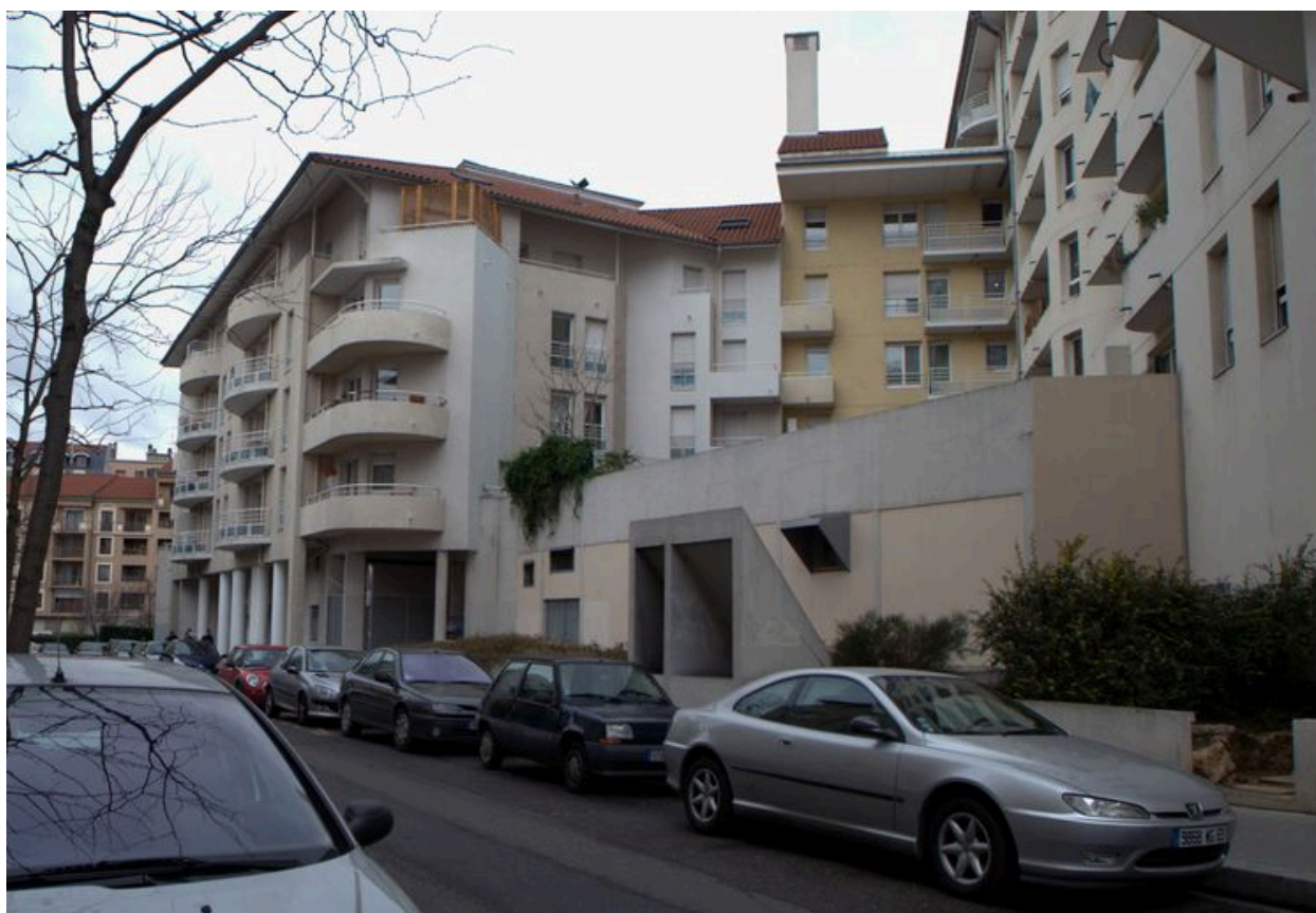
Elévation antérieure, vue d'ensemble depuis l'est
