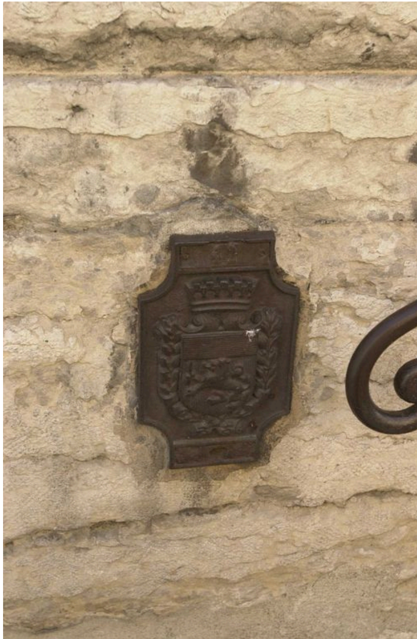
Borne d'altitude placée sur la façade principale
