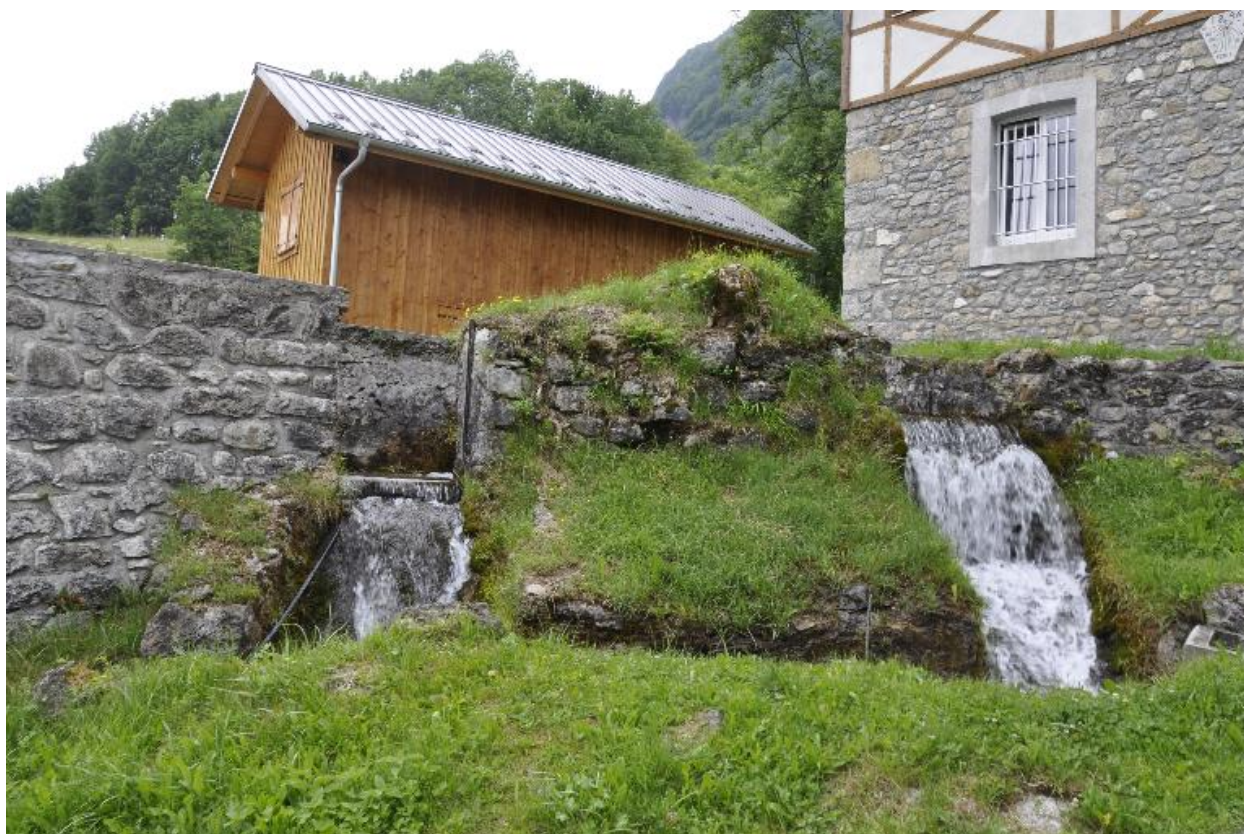
Trop plein du canal
