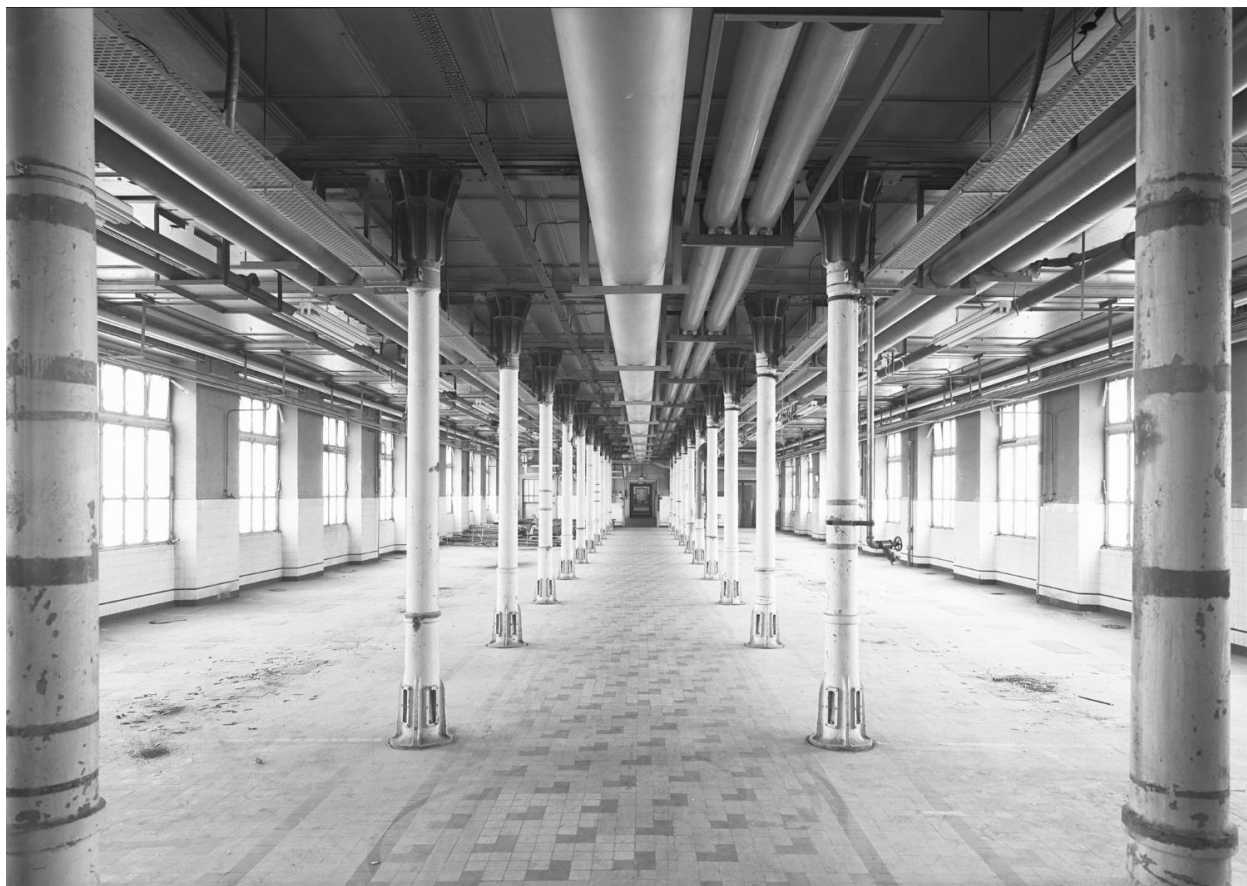
Atelier du bâtiment B, premier étage, vue direction sud
