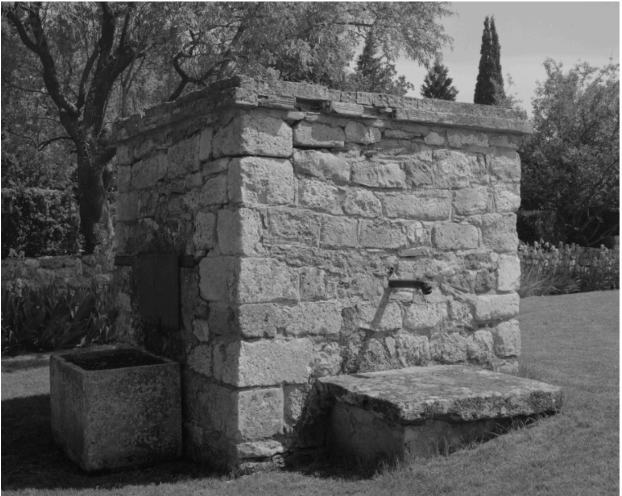
Puits situé dans le jardin du château.
