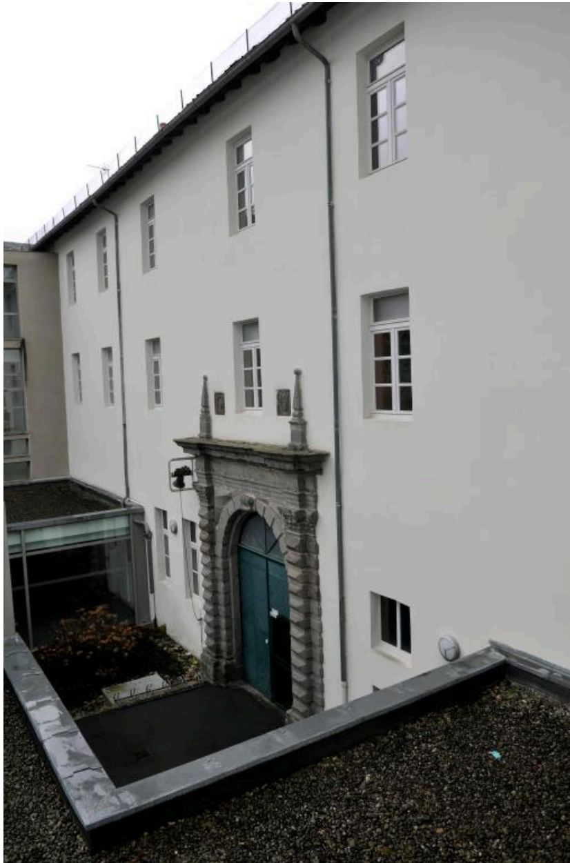
Bâtiment A : élévation sur cour, depuis le nord
