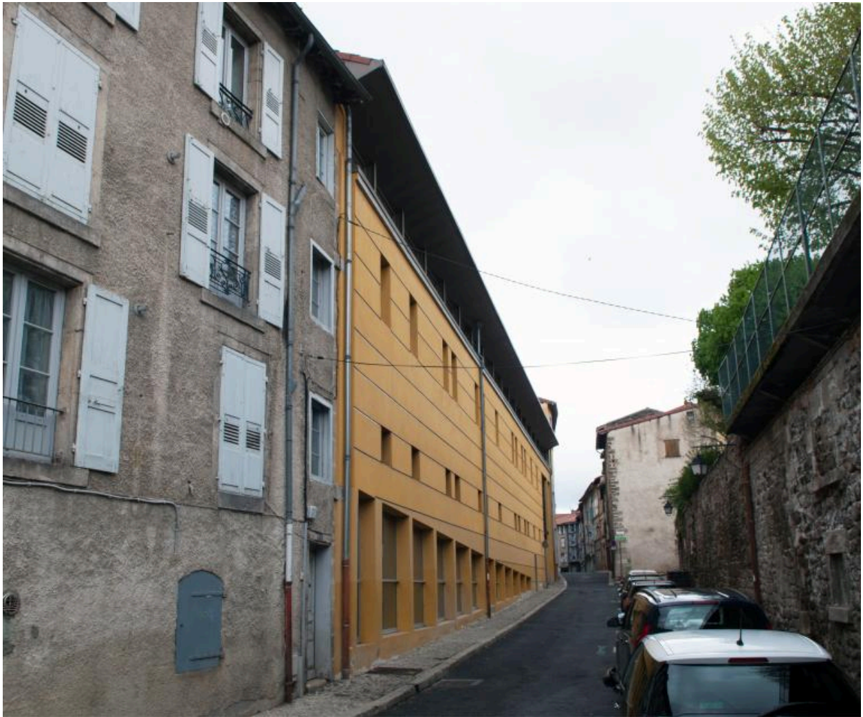
Bâtiment H : élévation sur rue, depuis l'est
