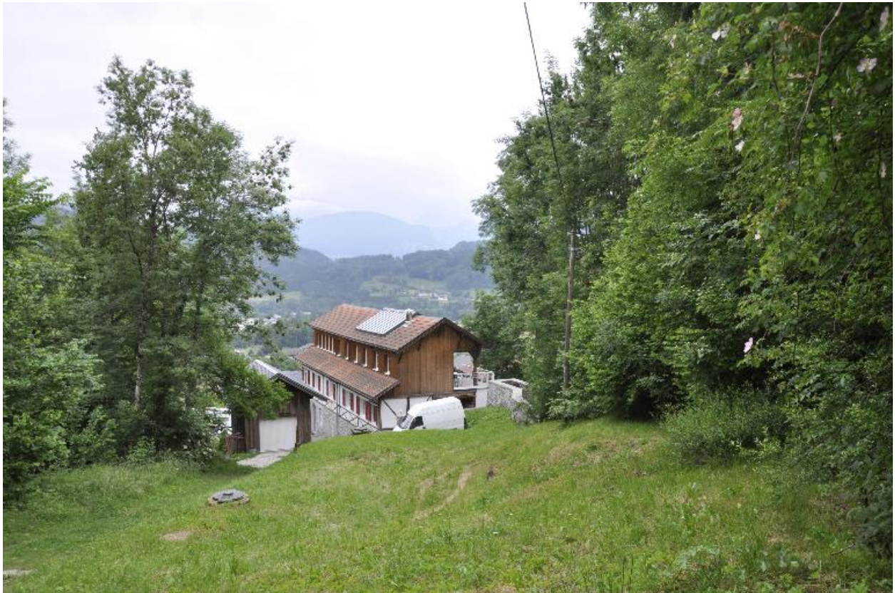
Vue de l'ensemble des bâtiments de la diamanterie prise depuis les sources alimentant le bief
