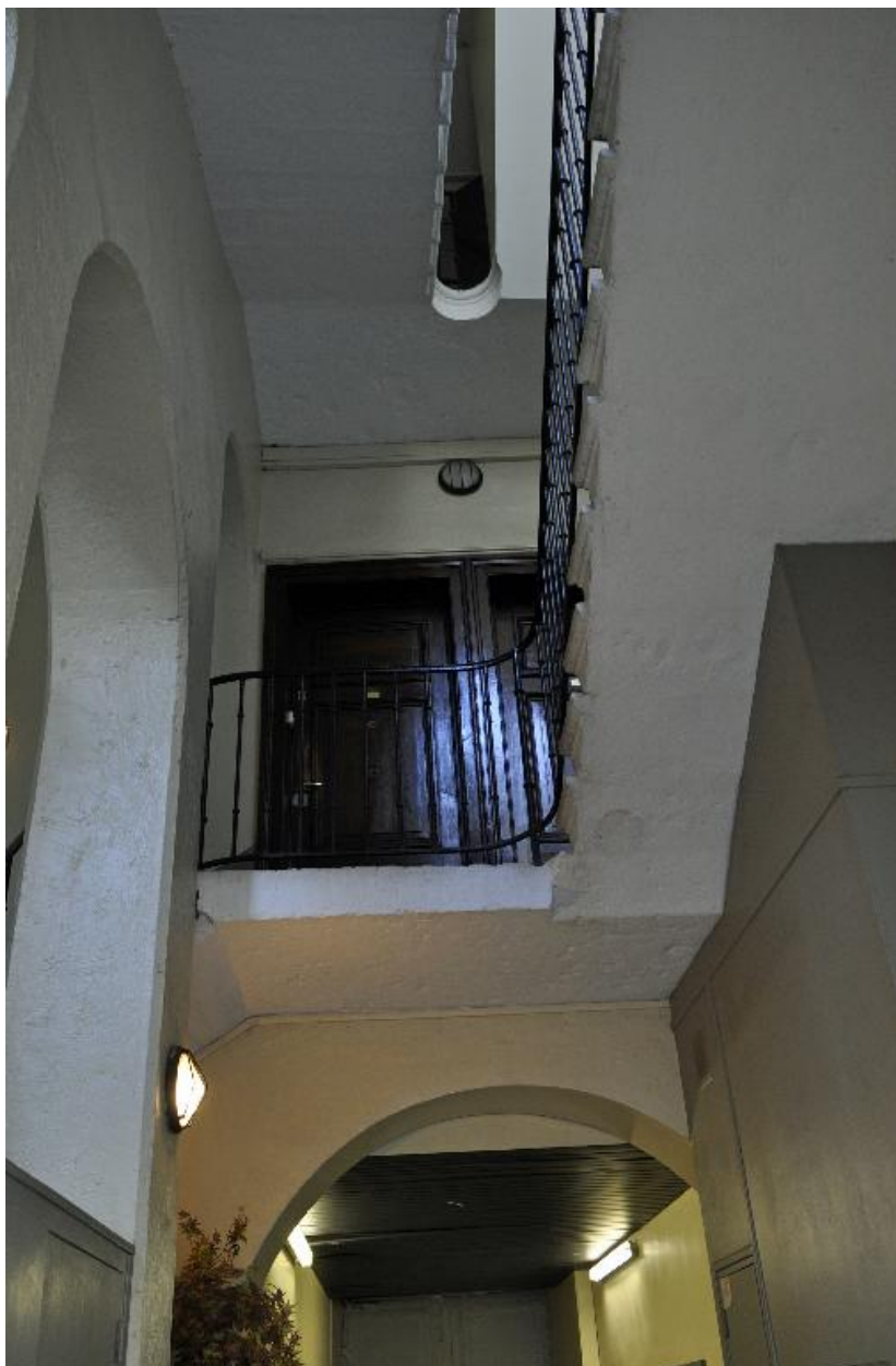
Immeuble sur rue, cage d'escalier
