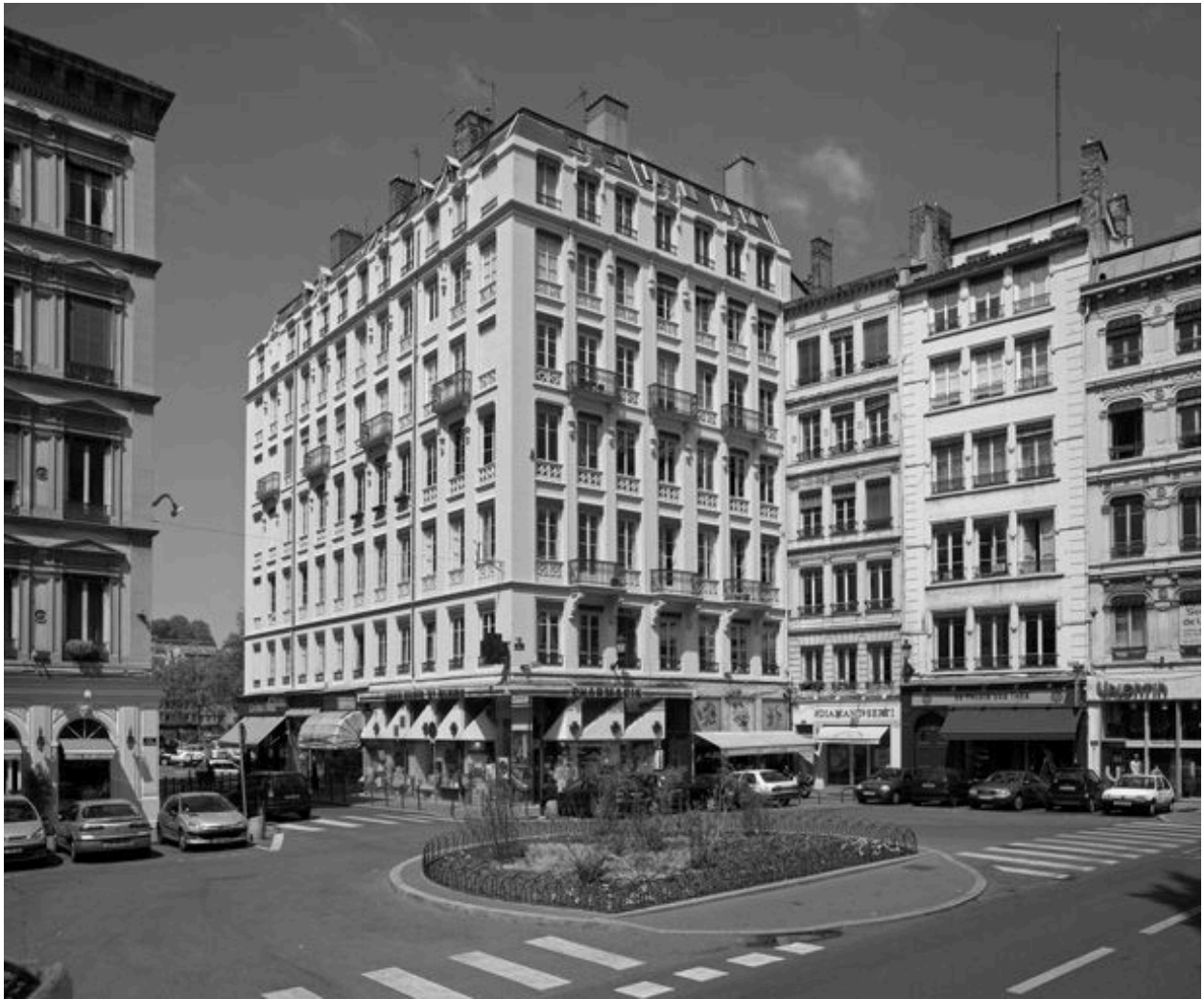
Vue générale de situation
