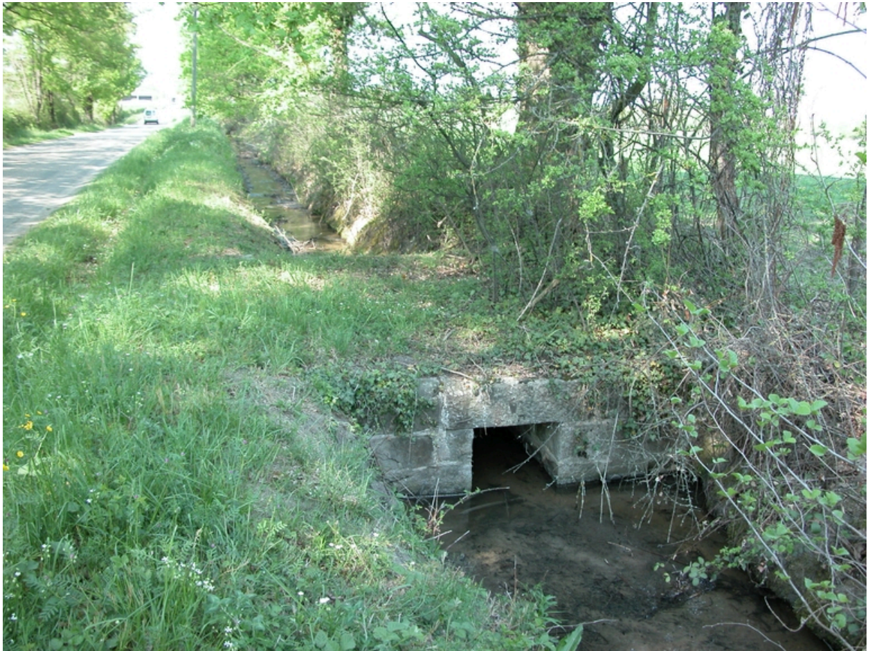
Artériole du canal du Forez à Chantegrelet : ponceau (section 1997 AL).
