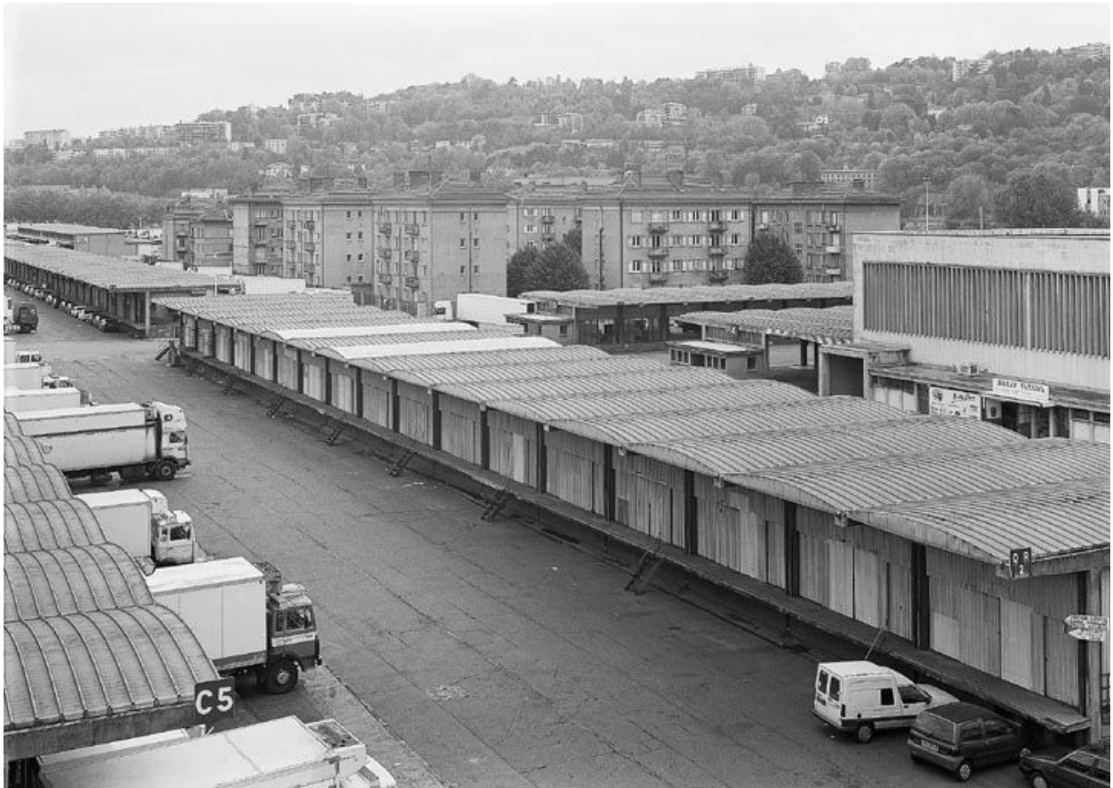
Le bâtiment Q-R 2 depuis le toit-terrasse du bâtiment administratif. A droite, la cité SNCF
