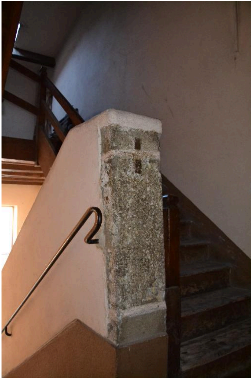
Escalier dernier niveau
