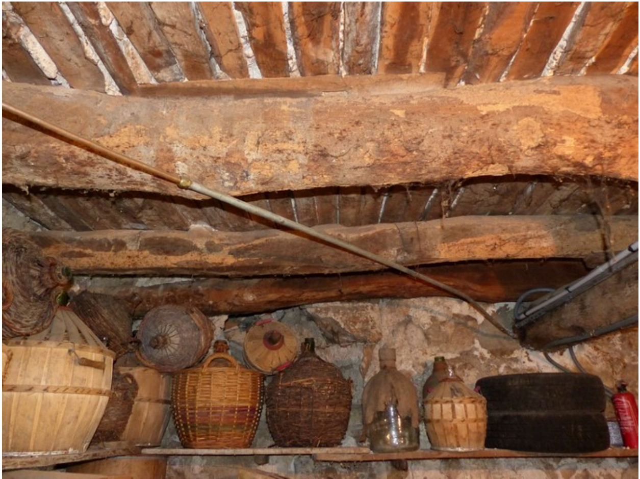
Bâtiment du logis. Etage de soubassement, cellier nord. Plafond et étagères.
