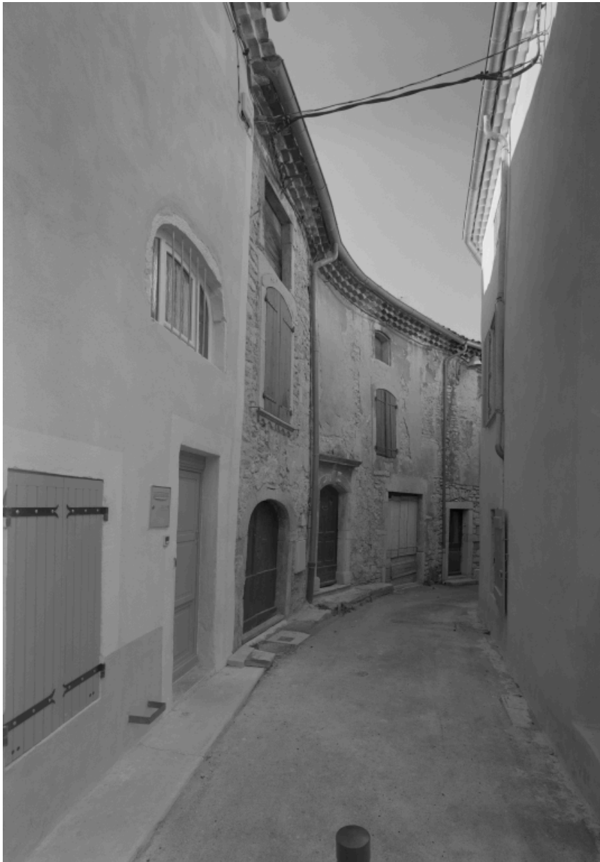
Rue Vieille Mérique, maison de type 6 (AX 18), façade modifiée aux 18e et 19e siècles, porte datée de 1810.
