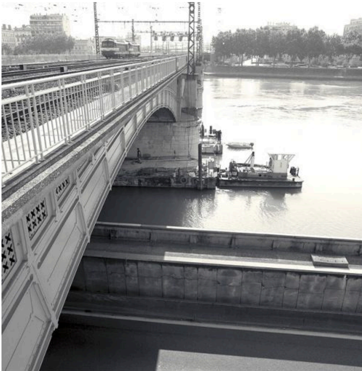
Vue des arches au-dessus du Rhône depuis l'ouest
