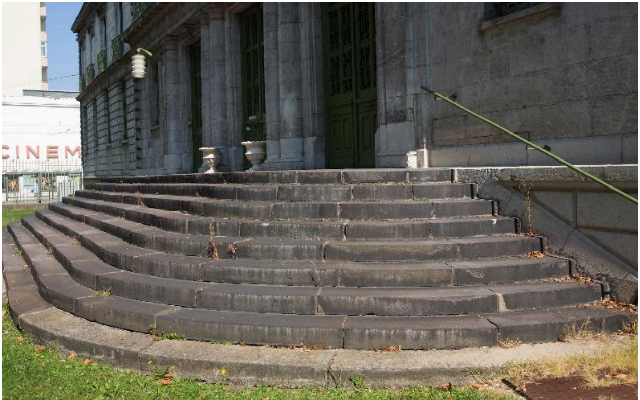
Escalier d'accès pour l'entrée principale du bâtiment A
