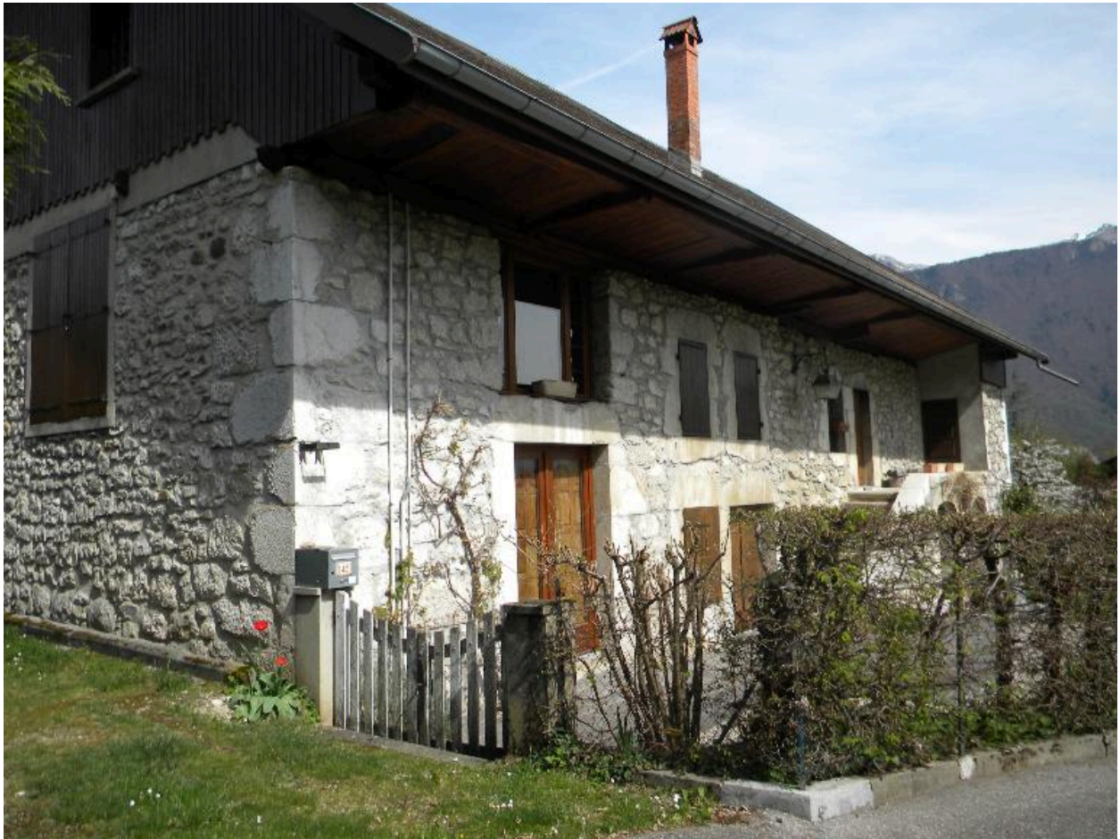
Vue de trois-quarts sud-ouest.
