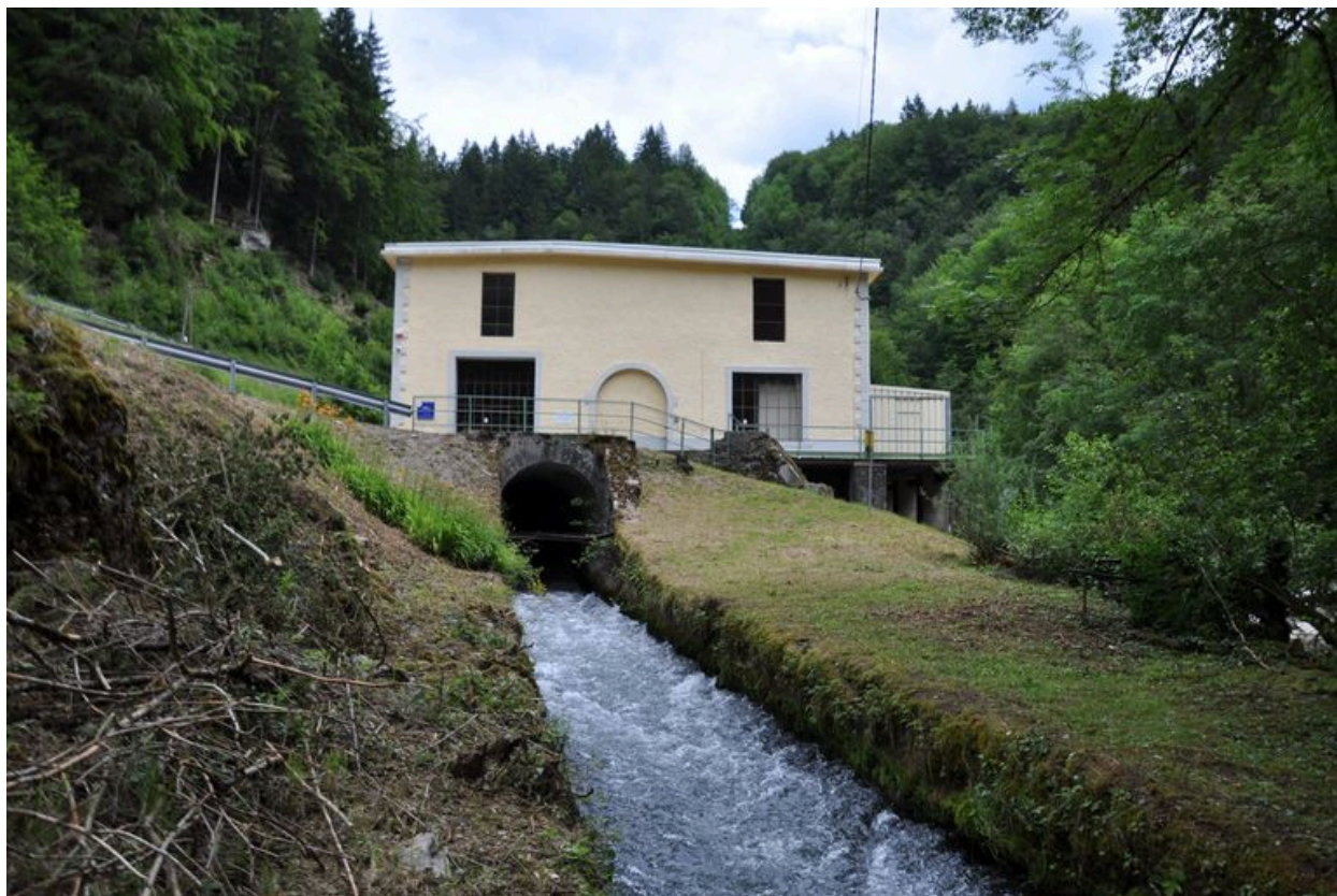
Vue du canal de fuite
