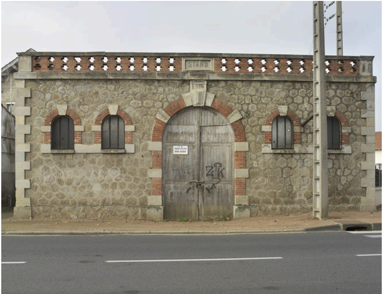
Vue d'ensemble du pavillon d'entrée.
