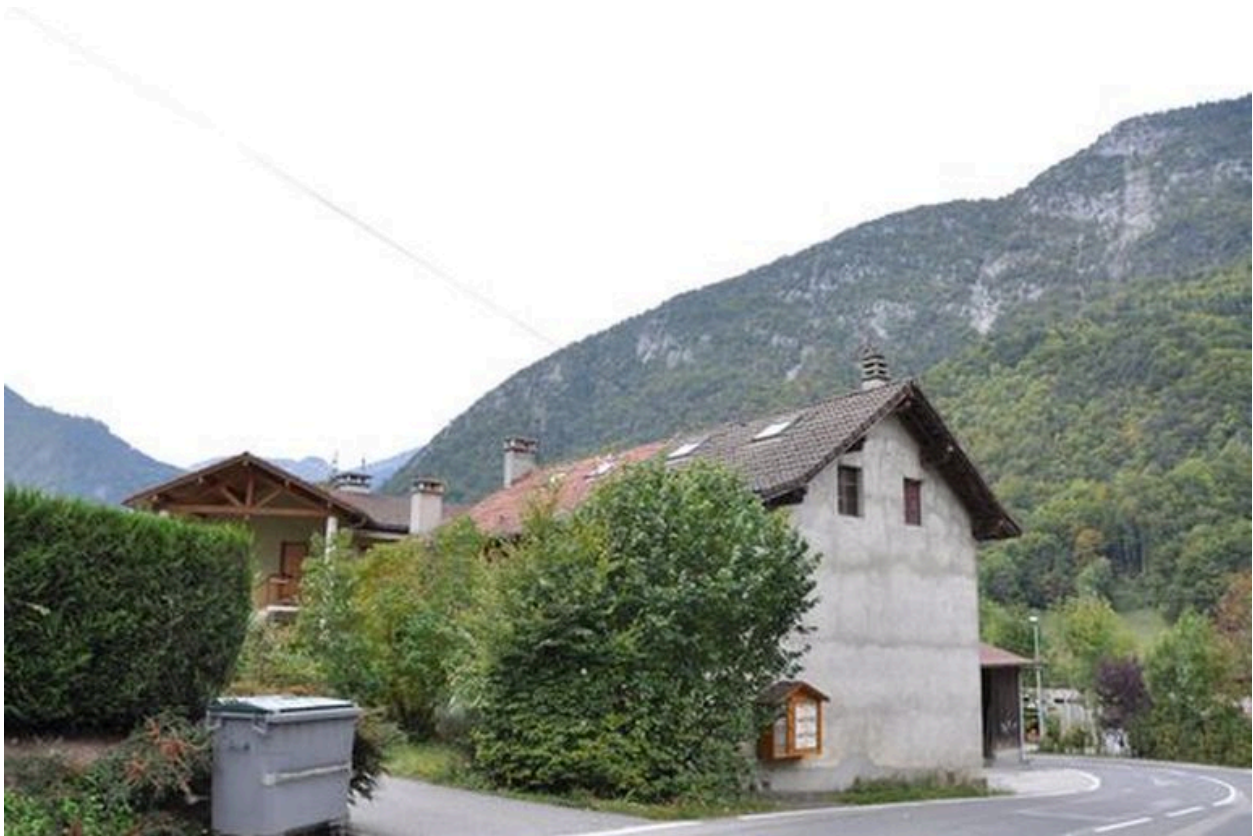
Elévation nord-ouest du bâtiment principal
