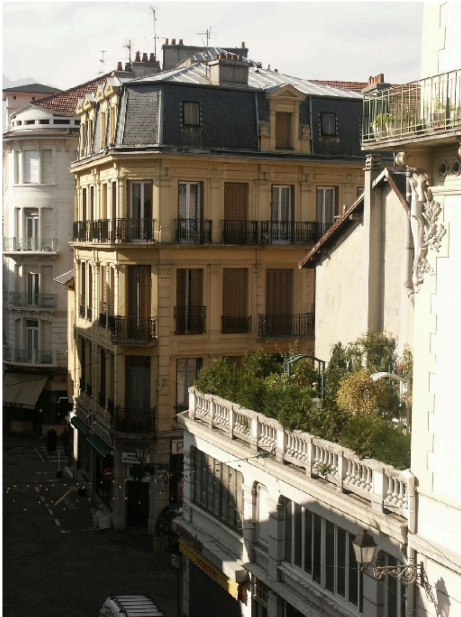
Vue générale depuis la rue Daquin
