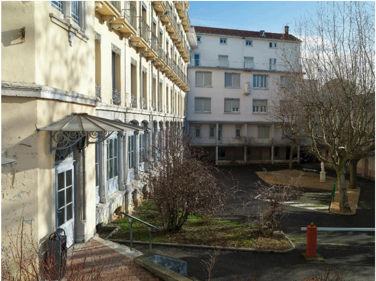
Vue partielle de la cour : ancienne maison de repos et bâtiment de la Communauté
