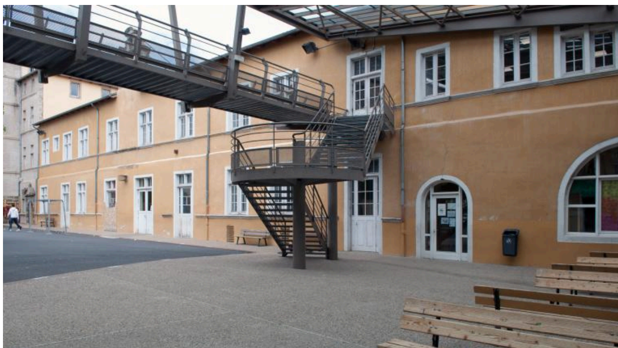
Bâtiment F : élévation sur cour 2, vue générale depuis le sud
