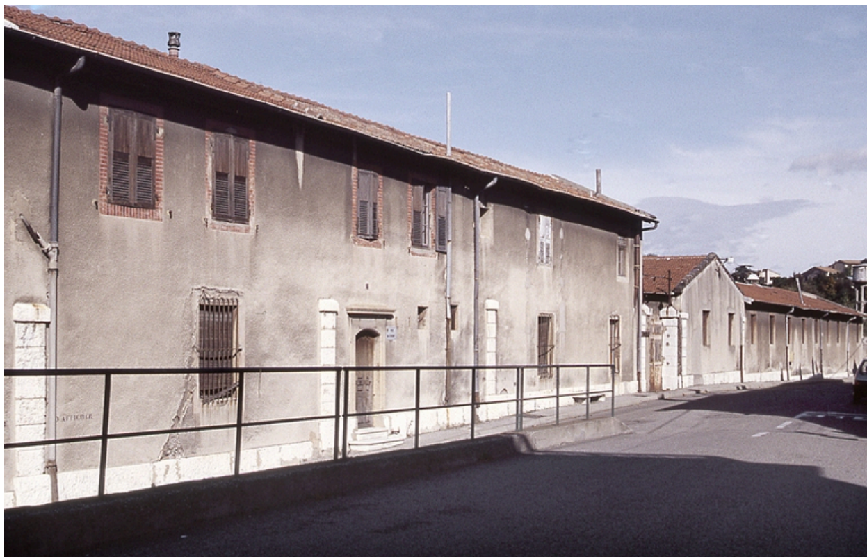
Vue est façade chemin de Chony
