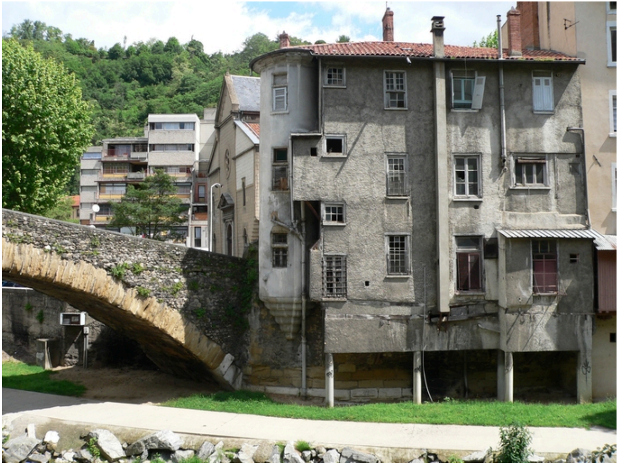
Façade sur Gère
