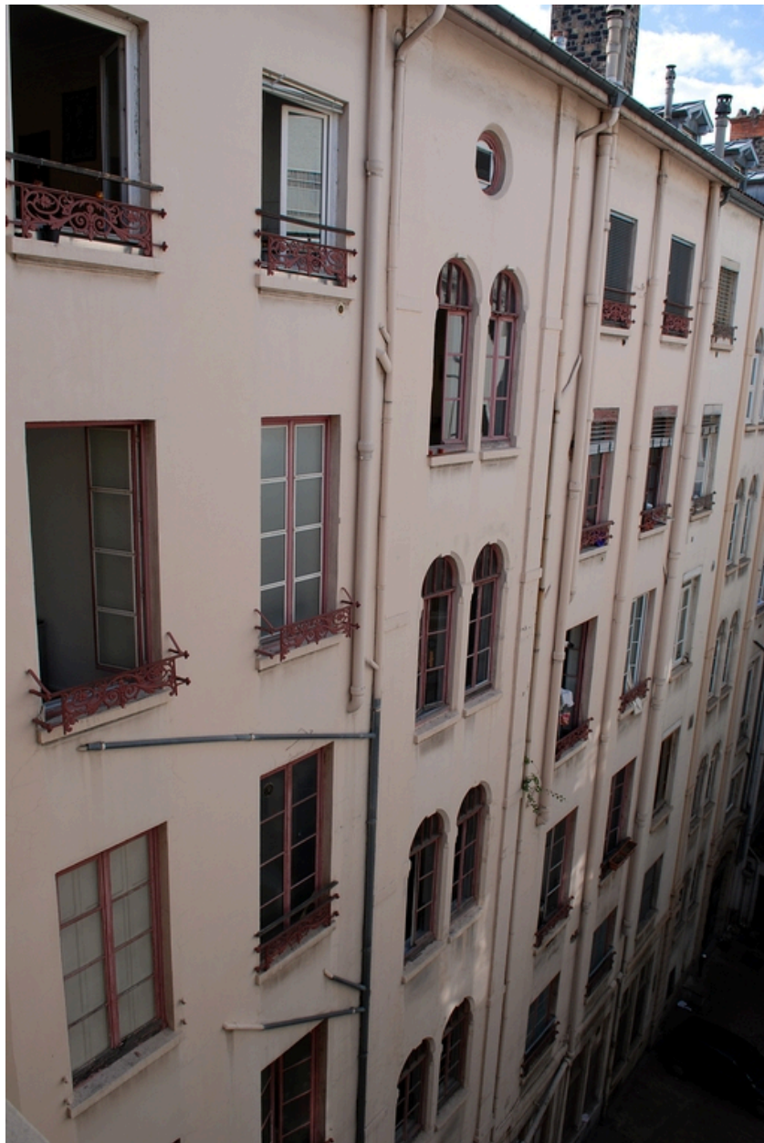
Elévation sur cour : vue partielle depuis l'escalier 4 rue Simon-Maupin
