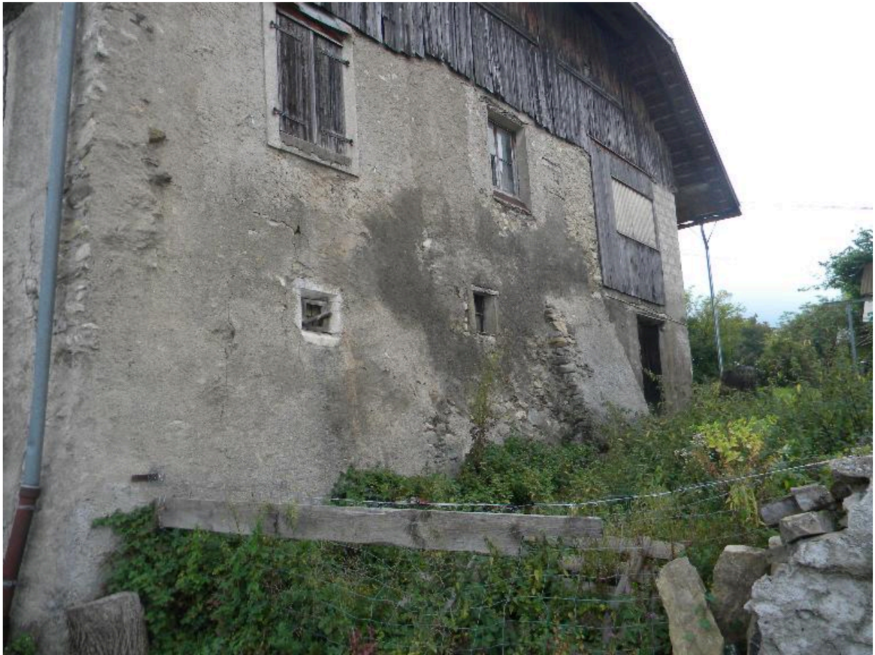
Détail du pignon ouest avec le contrefort.
