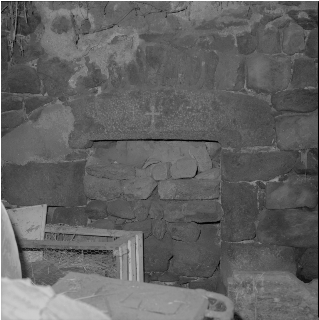
Intérieur du logis, détail d'une porte murée, au linteau en accolade et gravé d'une croix.
