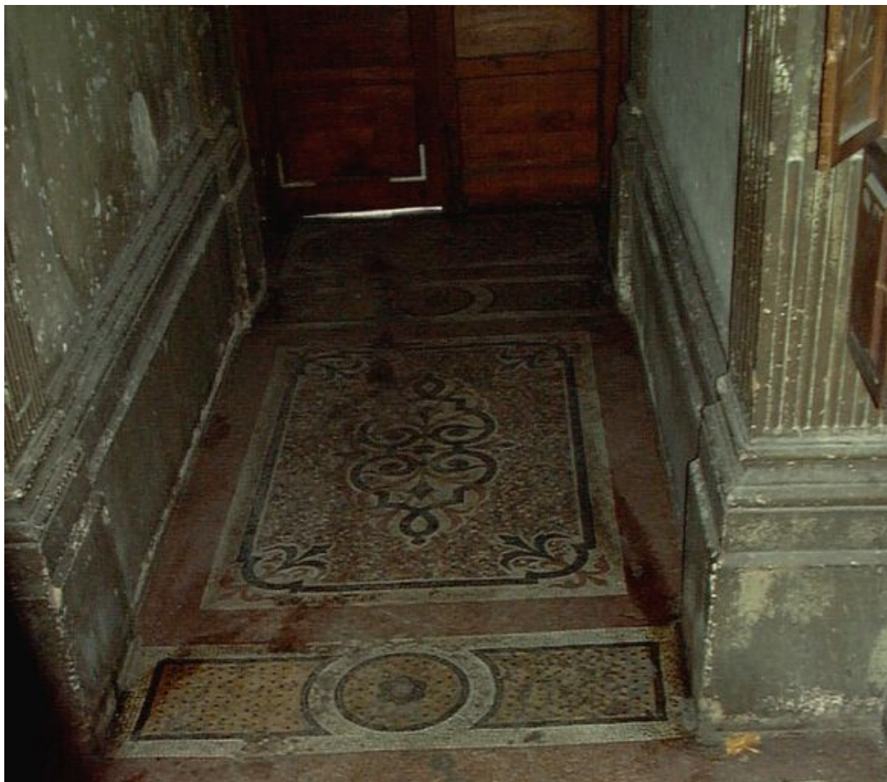
Détail du pavement du vestibule
