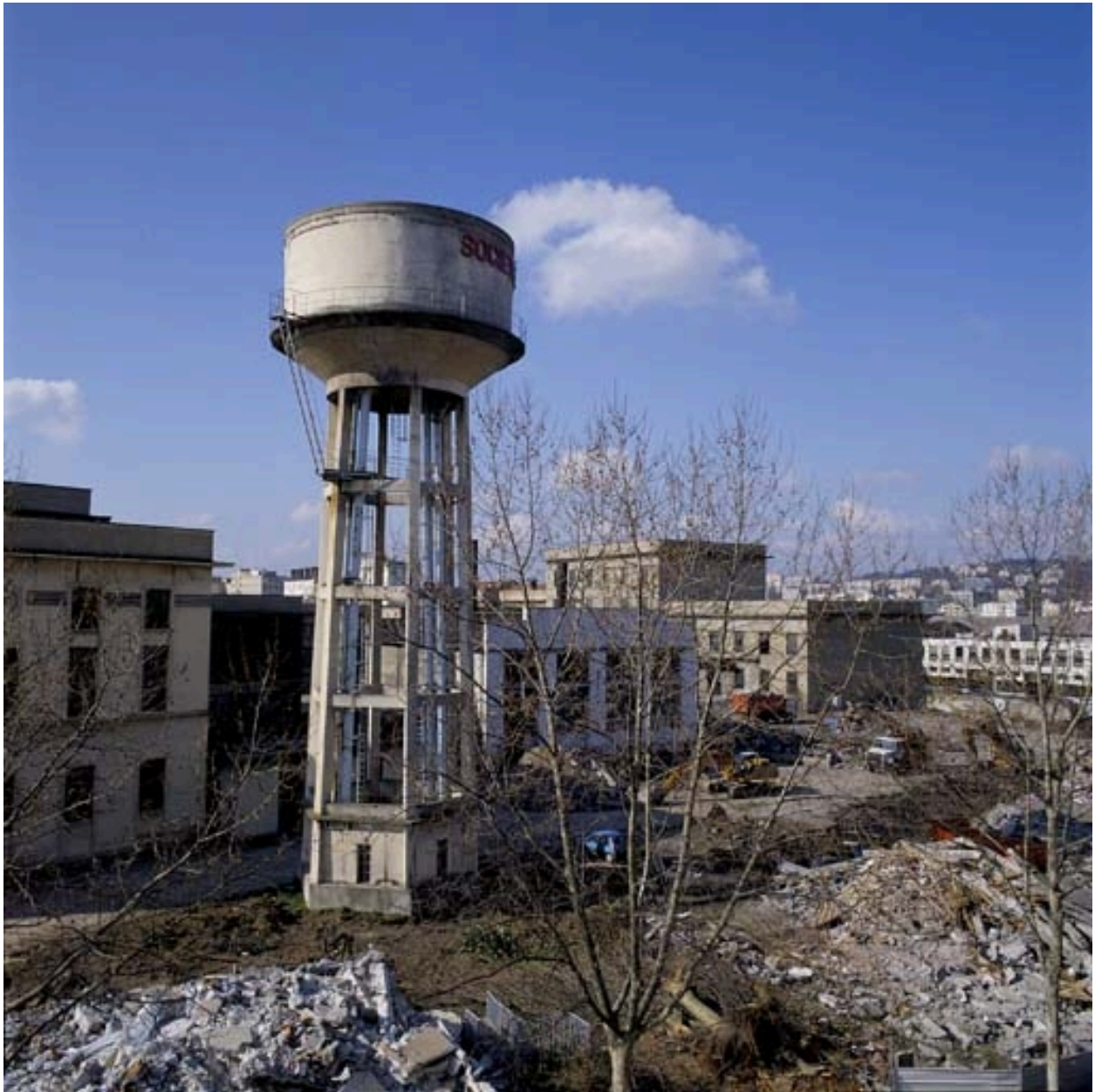
Château d'eau vue sud-est
