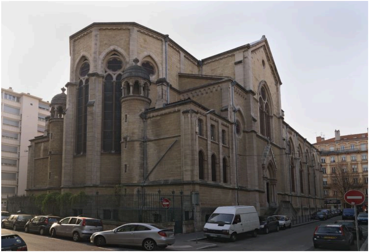
Vue des élévations est et nord.
