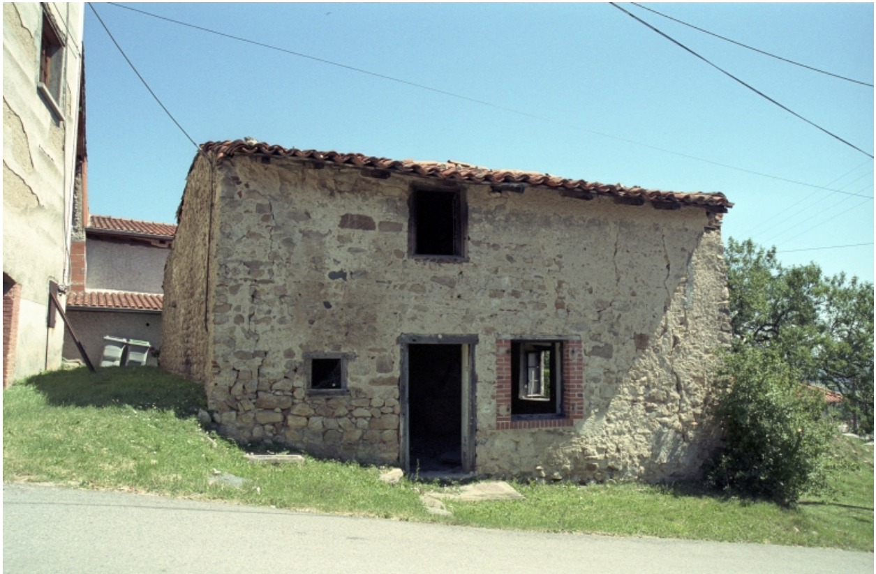
Le Bizay, ferme (1987 A2 607). Vue de la façade antérieure.
