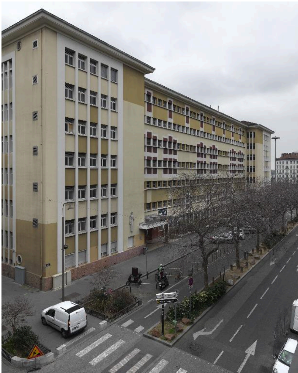
Elévation principale depuis le nord
